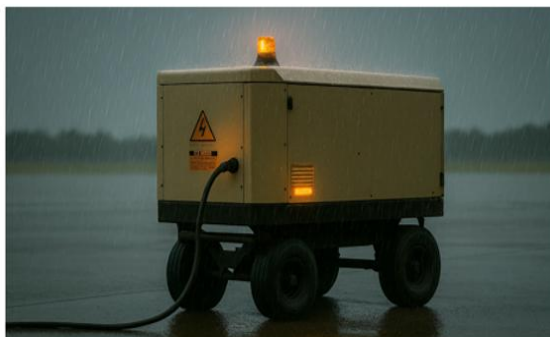
ABANDONO DE GPU ENCENDIDA EN PLATAFORMA EN CONDICIONES DE LLUVIA INMINENTE
