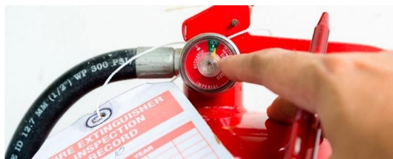
En caso de que el indicador se ubique en la zona roja, esto puede deberse a la sedimentación del agente extintor dentro del cilindro; para corregir esta condición, y únicamente si la normativa y el tipo de extintor lo permiten (no aplica para extintores satelitales), retire el equipo de su soporte de manera segura, inviértalo cuidadosamente en dos ocasiones y agítelo suavemente para redistribuir el agente.
